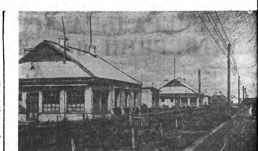
Алтайска хиазартахи тракторна заводой поселогто хоер квартиратай 128 кой, нэгэ квартиратай 70 гөрнүүдэй барилга ахлэгдэе. ЗУРАГ ДЭЭРЭ: баригданаһан шавэ гөр нүүд.
