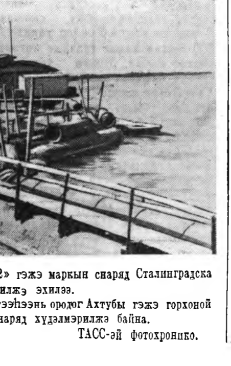
Газар үрэхин малтадаг «Волжский-12» гэжэ маркын снаряд Сталинградска гидроэлектростанцийн барилгада хүдэлмэрилжэ эхилээ.
