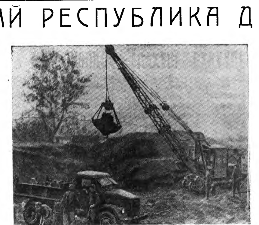
ЗУРАГ ДЭЭРЭ: Тохойско ГЭС-эй барилта. СУТА—1 экскаватор шлюз-регулятор тодохо котлован бэлдхэжэ байна.
