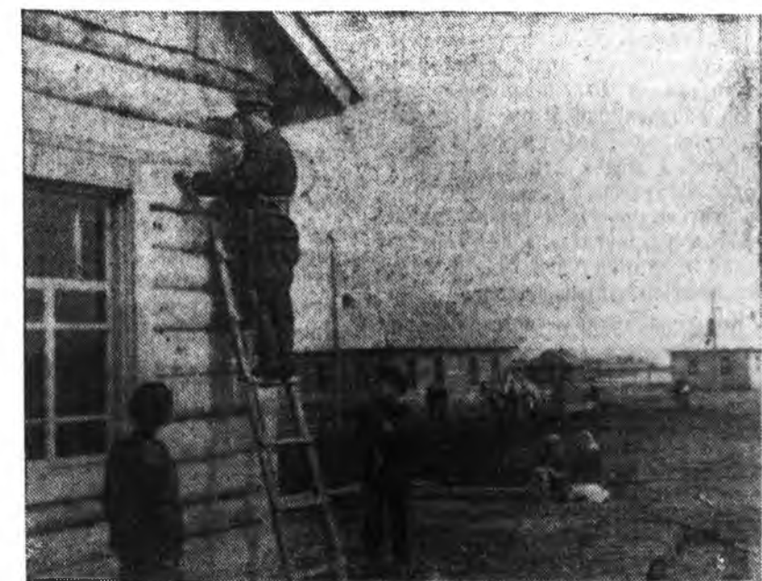
Долоон жэлэй хургуулин хүүгдэй байха хамтын байра, агрооотехническэ кабинет болон библиотека йруулын мяханай овоходо баригдажа хүүрбө. ЗУРАГ ДЭЭРЭ: совхозой электромеханикэ библиотекын байшанда электротехническэ провада оруулжа байна.
