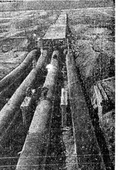
Азербайджанскэ ССР. Самур-Динчи-нскэ канал хобдорхи элэжэнэй барилга үргөөр дээрнхэй. Шэнэ улан магистраль 84 километр татагдаха юм. Барилганд хүсэтэ шэнэ техника хэрэглэн, унахай хаалтанууды болон гидротехническа бусад барилганууды хэжэ байна.
