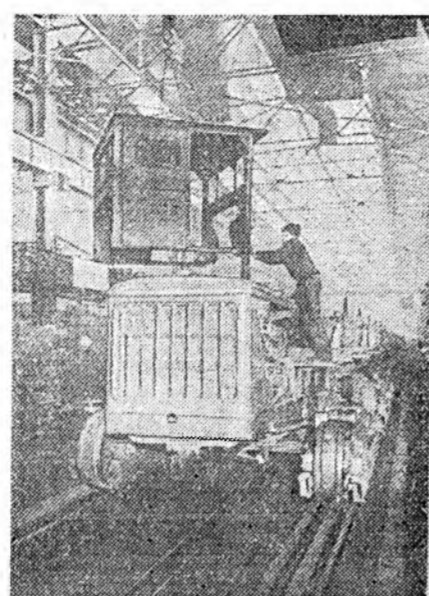
Алтайн, Казахстанай ба Сибирин шэнэ газарнууд дээрэ хал байгуула- гдан совхозуудай захилнуудыг Челя- бинска тракторна завод дүүргэнэ. Тус заводой главна конвейернэ түсөөн гадуур бүтээгдэнэ «С-80» маркын тра- кторнууд үлэр бүри гарана.
