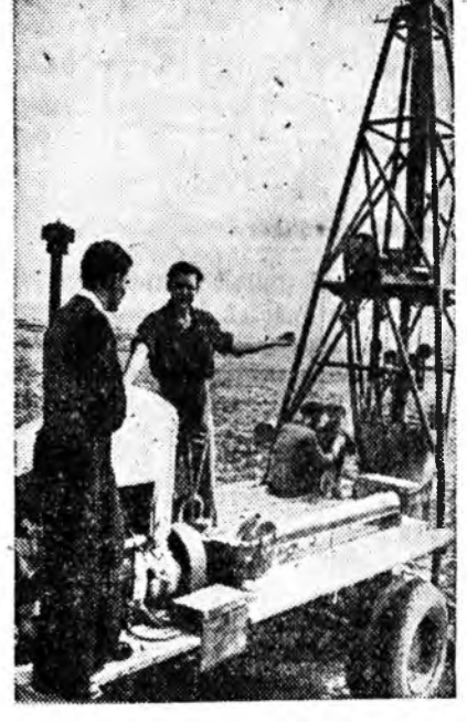
Иркутскта область. Братскта ГЭС-эй баригдажа байһан газарта Мосгидроэнергостройктан Ангарска комплексно экспедици шанжалдагта-бадартал хүдэлмэри хэжэ байна.
