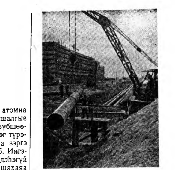
Красноярск город. Етсей мурнай баруун эрье танигдахгүй болотороо хубилжа байна. Тэндэ индустриальна, промышленна хада хаан томо предприяттиүүд баригдана. Шэнэ гэр байрнууд, кварталнууд данхайн болоно. Мүнөө үездэ Етсей мурнай баруун эрьдэ баригдажа байһан шэнэ кварталнууд руу теплофикацияно харгы татагдажа байна.
