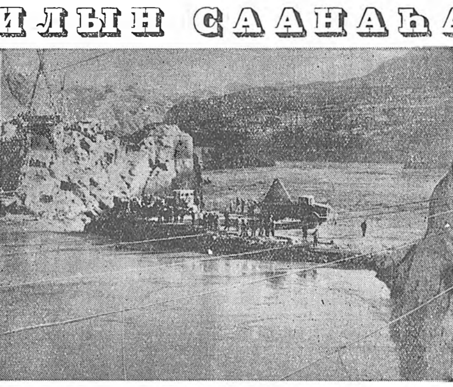
Хитадай Арадай Республика. Шаньши город шадар Хуанхэ мөрүн дээрэ «Сань-мынься» гэжэ гидроэлектростанци Советскэ Союзай туйлаамжалтайгаар баригдажа байхтай. Зураг дээрэ: хаалта хөнджэ байна. Синьхуа агентствын фото.
