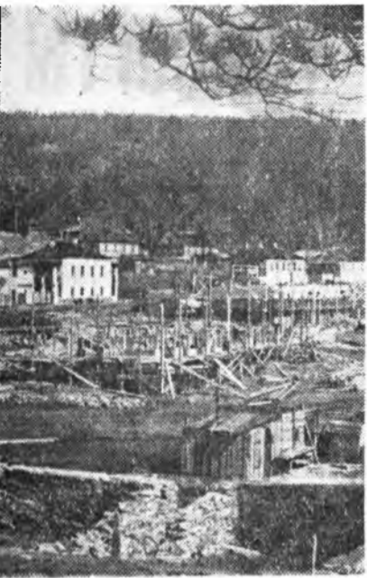
ЗУРАГ ДЭЭРЭ: ПВЗ-гэй хоёрдохи участогой саанаһана, гурбадахы барилгын талмай дээрэ бодоһон хүдэлмэришдэй шэнэ тосхон харуулагдана.
