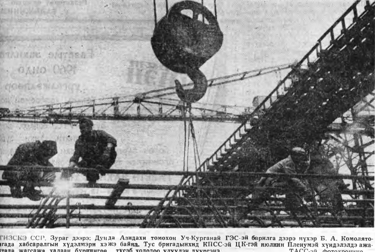
ЭРГИЗСКЭ ССР. Зураг дээрэ: Дунда Азидахи томохон Уч-Курганай ГЭС-эй барилга дээрэ нүхэр В. А. Комолято-вгада хабсаралгын хүдэлмэри хэжэ байна. Тус бригадынхид КПСС-эй ЦК-гэй июлин Пленумын хүндэлдэ ажа-мтада жагсажа халаан бүрингөө түсэб ходоодо үлүүлэн дүүргэнэ. ТАСС-эй фотохонико.
