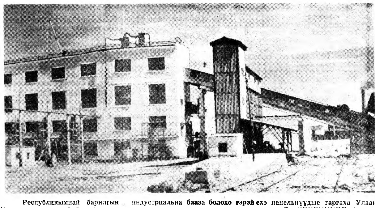
Республикнай барилгын индустриальна база болохо гэрэй эхэ панельүүднэ гаргах Улаан-Удын шэнэ заводой барилга.
