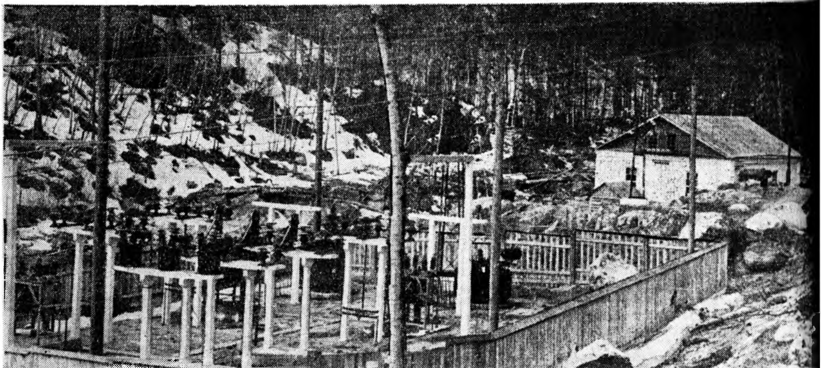
Баргажанай аймагай Хурум хаанай ГЭС. Наада таладань электрын элшэ дамжуулаха подстанци.
