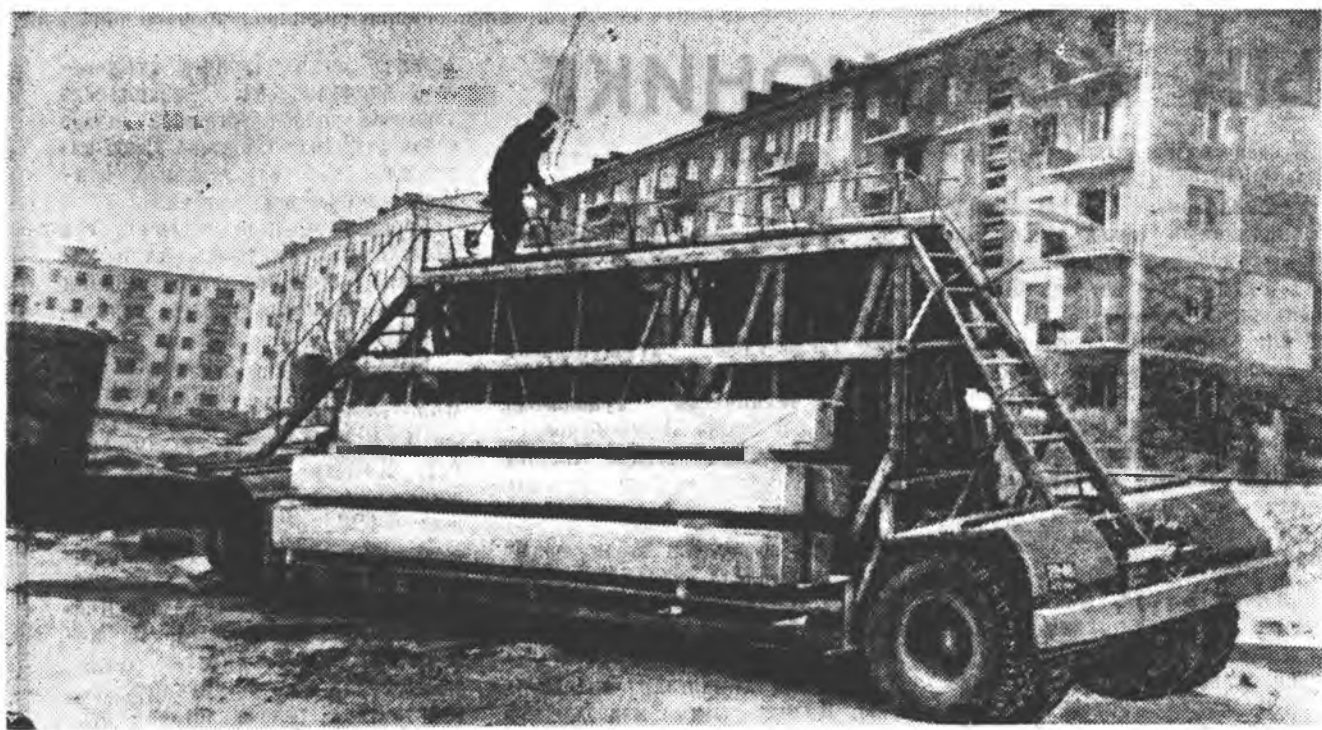
Улаан-Удны барилгын талмайнууд дээр жөл ерэхэ бүри шэнэ техникэ хэрэглэгдэжэ, барилгаша- дай ажал улам хүнгэдэнэ. Октябрыска райондо томо панелсэр хэдэн гэрүүд баригдаа. Зураг дээрэ: гэрэй панельнууд барилгын талмайда асаргадаг, буулгадажа байна.
