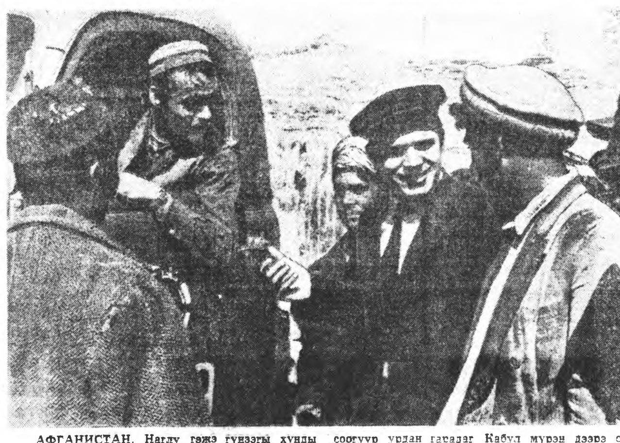
АФГАНИСТАН. Нагду гэж гүзээгэй хүндэ соотуур урлан гаргал Кэбул муран дээрэ орон доторхи тон томо гиродлектростанци Советска Союзай туһаламжатайгаар баригдажа байна.
