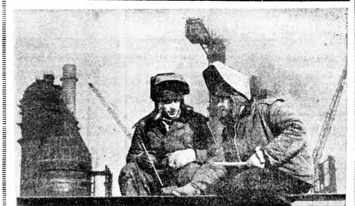
Казахстанай Магнитнын табигдаха ёһотой шэнэ объектн барилгашад «Гурбадахы домнын үлхөө барилганууды 1970 ондо тушаа» гэһэн уриагайгаар хүдэлжэ байна. Домнын ашаглагдажа эхилхэдэ, Карагандай металлургоска заводто шэрэм хайдуула хоёр дахин эхэ болохо. Зурга дээрэ: электро-гагшагшад Михаил Волосатов (зүүн гарһаа) Юрий Голованов хоёр. Тэдэнэр Казахстанай домнын барилгада эрхмээр хүдэлнэ. ТАСС-ай фотохронико.
