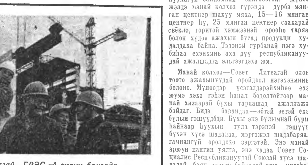
ЗУРАГ ДЭЭРЭ: Литвагай ГРЭС-эй түрүү бригада.
