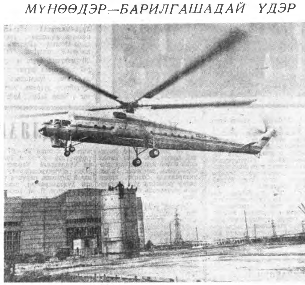
СВЕРДЛОВСКО ОБЛАСТЬ. Түмэр хоолойнуудые гаргадаг Синарска заводой «В-3» гэдэг цөхэй агаарта «МИ-10К» гэдэг вертолёт-механизмуудай хэрэглэгдэжэ болохгүй газарта 400 метр дээрэ үндэр башен на түүхэй 4 скруббер-кап-хэрэгтэй. Тиндэ 10 тонно шаггуртэй томодогдоһон урғышын тулада вертолётдай агаарта дэгдэжэ, нийдэгдэ-сатарьн, дунда зэргээр 12 минута са гаргадаг. Эдэ оройдоол гурбан миллиметр эй нэлгээтэйгээр тон зүбөөр, Челябинска «Востокметаллургмонтаж» трестдэ түмэр зүйлнүүдые зөөхө ба хаб. саргаха хүдэлмэри дүүргэгдэ нэ. Нимэ хүдэлмэрийн эхин март, апрель нарада табигдаа юм. Тинхэдэ скруббернуудай томодогдоһон блогууд «АТ У-25» гэжэ тухай автотран-спортна тухээрэлгын туһала мжаар Челябинска Каменс к-Уралы асаргада. ЗУРАГ ДЭЭРЭ: вертолёт ашаа абажы байна. ТАСС-ай фотохронико.
