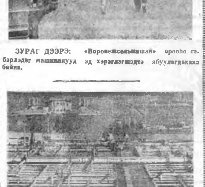
Волгоград хиническэ комбинадай гарган муухай үһые биологическа аргаар сөбөрлэдэг түхээрэгдэнүүд ороноймнай химическа предпритниудай дунда эгээл һайн гэжэ гүрэнэй комисс сэнхэнэн юм. Энэ комплекс сүүдхэ соо 150 мянган кубометр уһа сөбөрлэхэ хүсэтэй. Волго руу дээршье муухай уһан хайгдаха болое.
