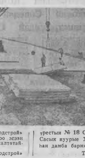
УКРАИНЫН ССР. «Дунайводстрой» трестын коллектив орон дотороо эгзэн тоого үнэлуурин системэ амжалтатайгаар бариха байхыг. ЗУРАГ ДЭЭРЭ: «Дунайводстрой»
