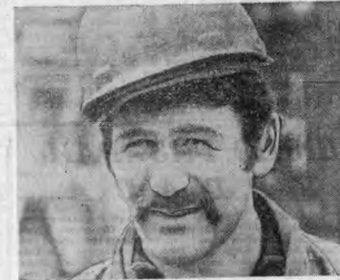
ЗУРАГУУД ДЭЭРЭ: 1. Байгалы тоннелин зүүн порталдахи забой соо. Ленинэй орденот кавалер Валентина Романович Толстоуховай бригада Байгалы тоннелин зүүн талаана 1980 метр малтаад байна. 2. Сүт хамта хүдэлжэ түүлхэ В. Р. Толстоуховые Бурядай АССР-эй Хойто-Байгалы районной хүндэт эрхэтэн гэжэн нэрэ зэргэдэ хүртэнтэйн дашарамдуулан амаршала байна. 3. Байгалы тоннелин прохочгунуудай комсомол-залуушуулай бригадын зөвнөй Тамаз Тхелидзе, Тэрэний эвено В. Толстоуховай бригадын эрхэм эвено гэжэ тоологдодог юм. Харин Тамаз «БМ-ай эрхэм прохочгун» гэжэн нэрэ зэргэдэ хүртэжэй.
