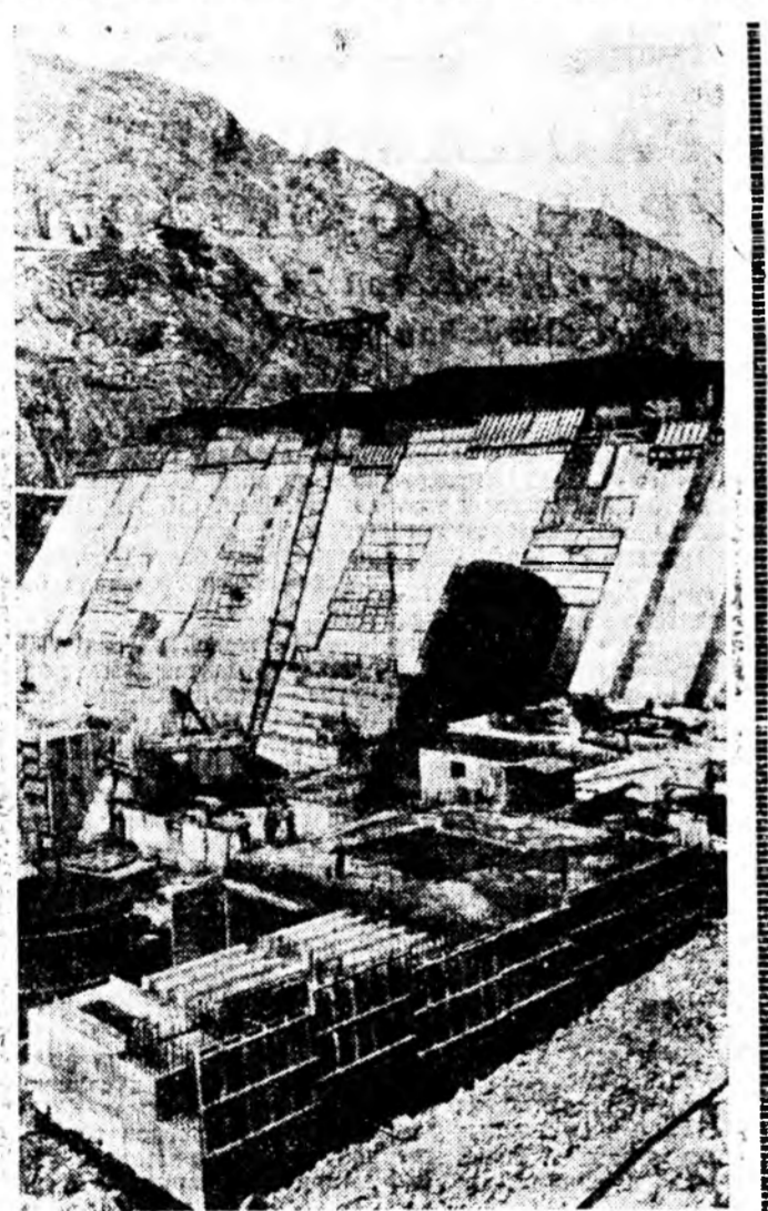
«1976—1980 онуудта СССР-эй арадай ажахы хүгжөөх гэдэ шалгэлдүүд» дотор заагданай ёһоор Нарын мурэн дээрэ Курсайска ГЭС баригдажа байхай. Тэрэний плотинода 360 мянган кубометр бетон шудагдаа. Энэ жэлэй нүүл багар станциин түрүүшүн аргават электрын элшэ хүсэ үгэхэ юм. Энэ мурэн эрвэдэ Киргизидэ эгээ залуу Кара-Куль город урган бодонхой. ЗУРАГ ДЭЭРЭ: Курсайска ГЭС-эй плотинын барилда.
