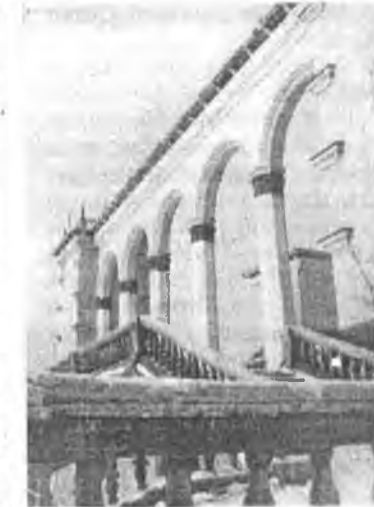
Южная аркада здания
