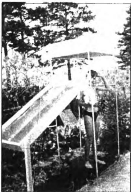
квартирных домах на период летнего отключения горячей воды и для дачных душевых установок. Эти установки могут готовить воду для бытовых нужд. Производительность их от 30 до 150 литров в сутки. В настоящее время завершаются работы по изготовлению солнечного концентратора для получения перегретого пара. Эта установка позволит использовать солнечную энергию для получения электрической энергии и горячей воды.
